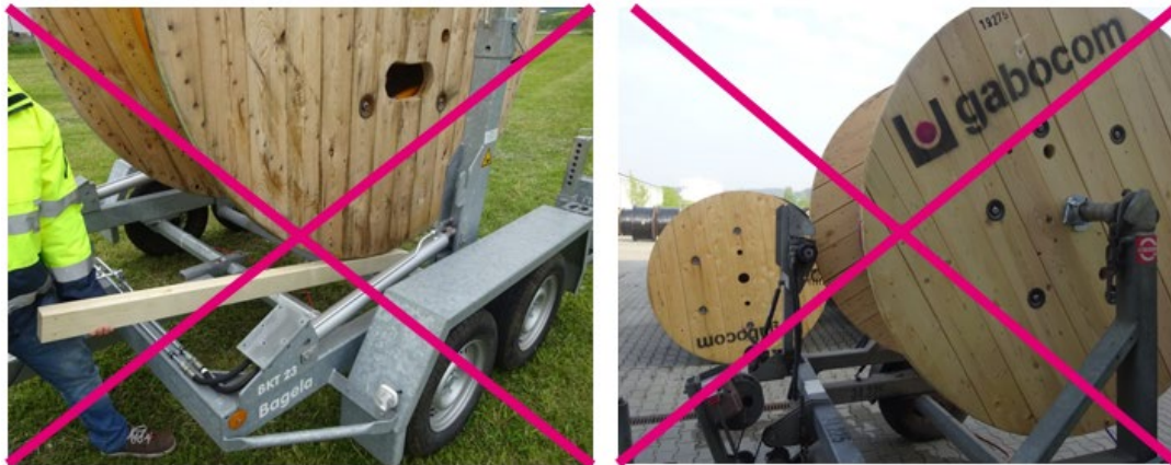
Abbildung 7 Beispiele ungeeigneter Methoden die Trommel zu bremsen
