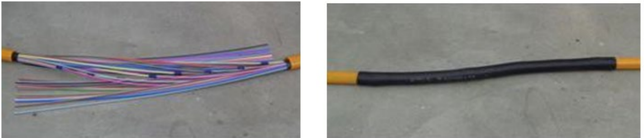
Abbildung 10 Zwei Schritte des Durchverbindens von SNRV-E
