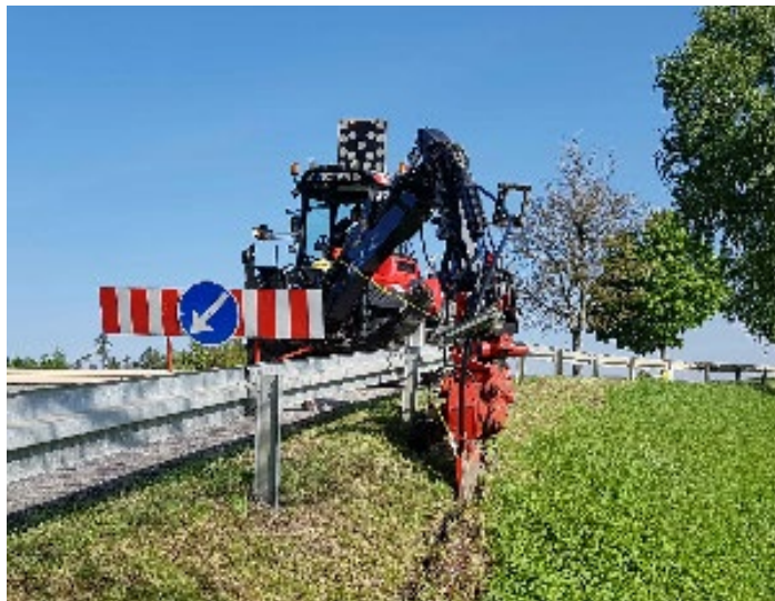
Abbildung 22: Hinter Leitplanken Pflügen (Bild: Fa. econtech)
